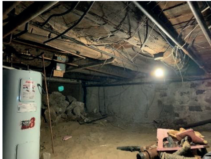
Rez-de-chaussée – Poutres en bois
