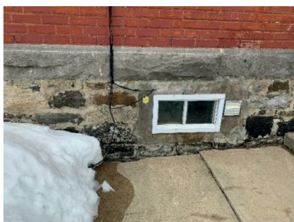
Mur au périmètre – face extérieure
