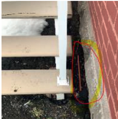
Figure : Tuyau d'alimentation en huile "enfoui" non protégé
