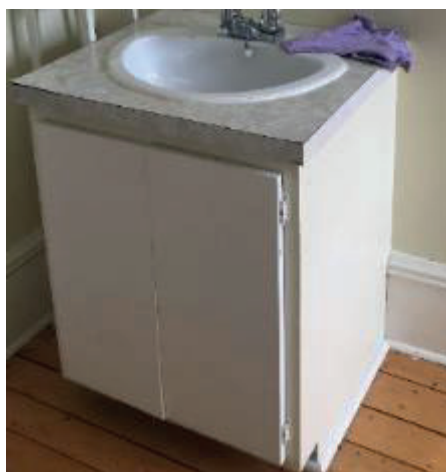
Figure : Lavabos (à remplacer)
