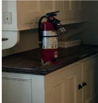
Figure : Extincteur portatif (prévoir un support mural ou cabinet pour extincteur)
