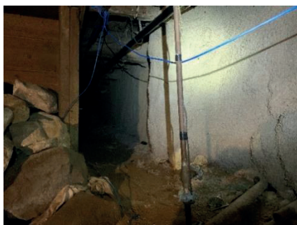
Mur au périmètre – face intérieure
