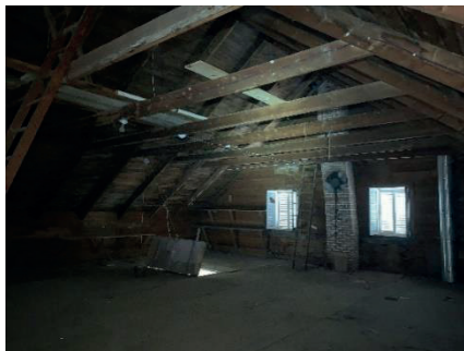
Toit- Fermes de toit
