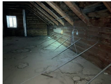
Toit – Renforcement des murs porteurs
